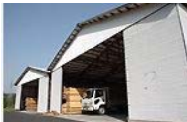
木材材質高度化施設装置（製品保管庫）
