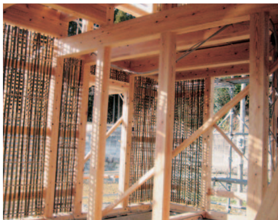
土壁補強材（竹）施工中（1階部分）
