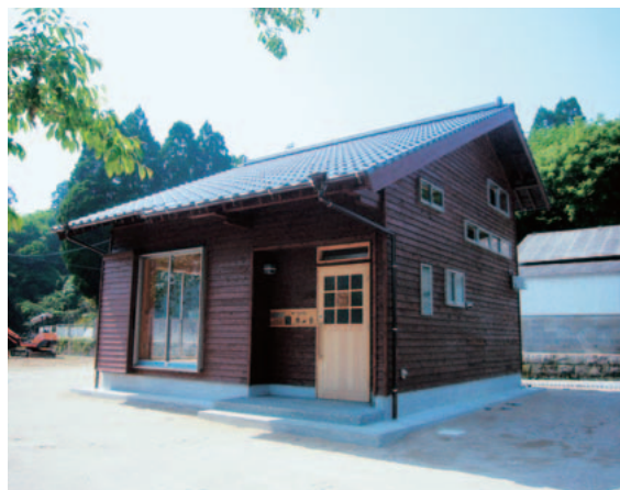
完成したモデルハウス
