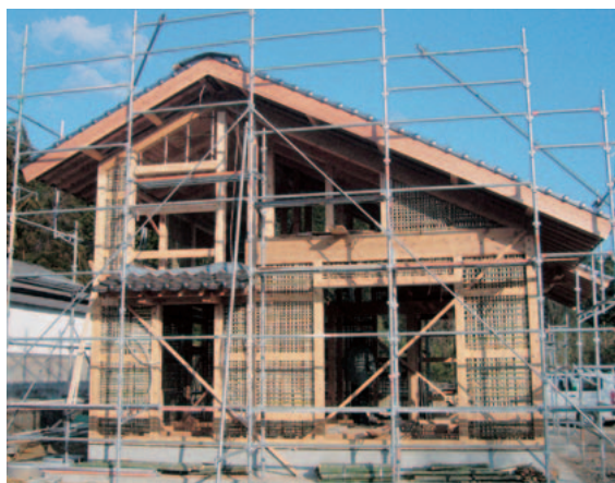
土壁補強材（竹）施工後（1階部分）
